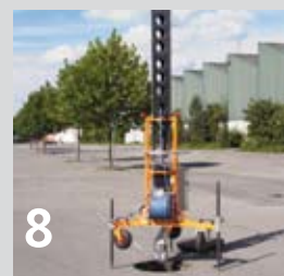
Kanaluntersuchung Schachtsinspektion und -vermessung
